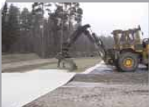
Dräneringsgrus läggs ut på bentonitmattan.
