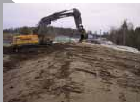
Utläggning av skyddsskikt.
